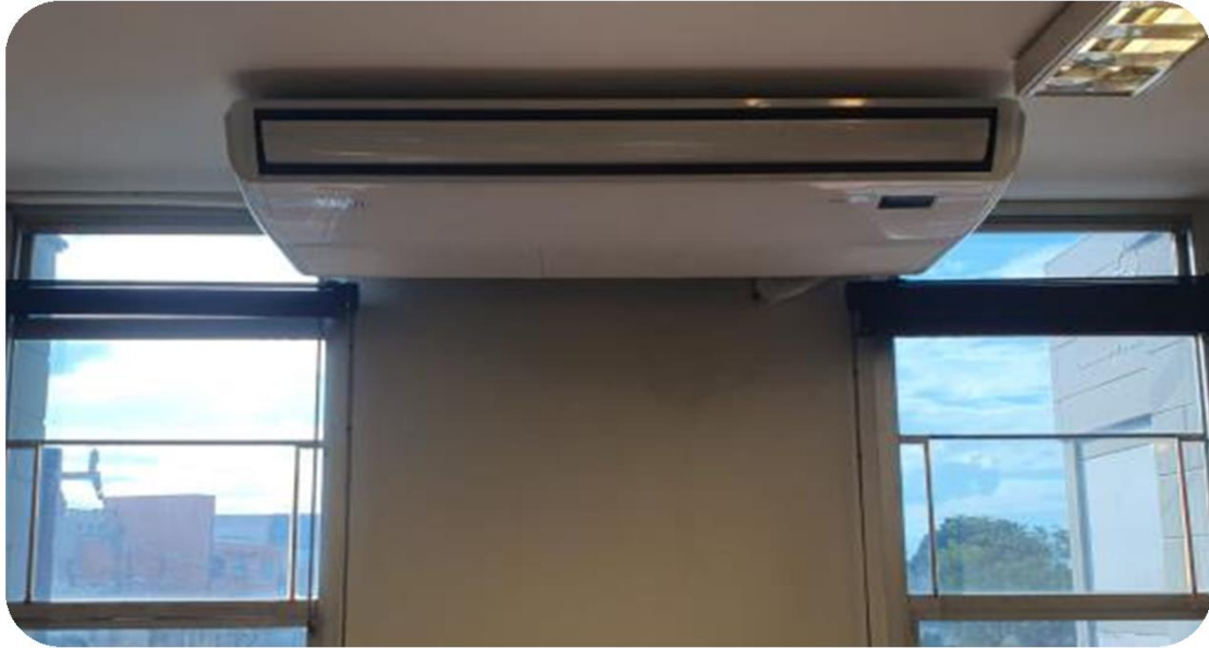
FOTO 1: Split 01 instalado na sala de aula FA-36, com capacidade de 48.000 BTU/h e tecnologia Inverter, que garante maior eficiência energética e climatização estável. Na referida sala foram instalados dois equipamentos de igual capacidade e característica.
