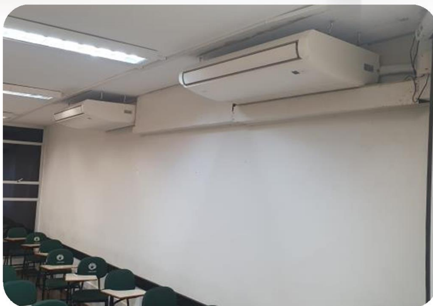
FOTO 4: Imagem, em outro ângulo, dos splits instalados na sala de aula FA-14, com capacidade de 36.000 BTU/h e tecnologia Inverter, que garante maior eficiência energética e climatização estável. Com a instalação dos dois equipamentos, será possível manter uma temperatura agradável e adequada ao pleno desenvolvimento das atividades de graduação no ambiente.
