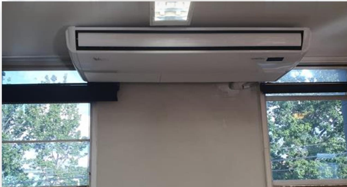
FOTO 1: Split 01 instalado na sala de aula FA-36, com capacidade de 48.000 BTU/h e tecnologia Inverter, que garante maior eficiência energética e climatização estável. Na referida sala foram instalados dois equipamentos de igual capacidade e característica.
