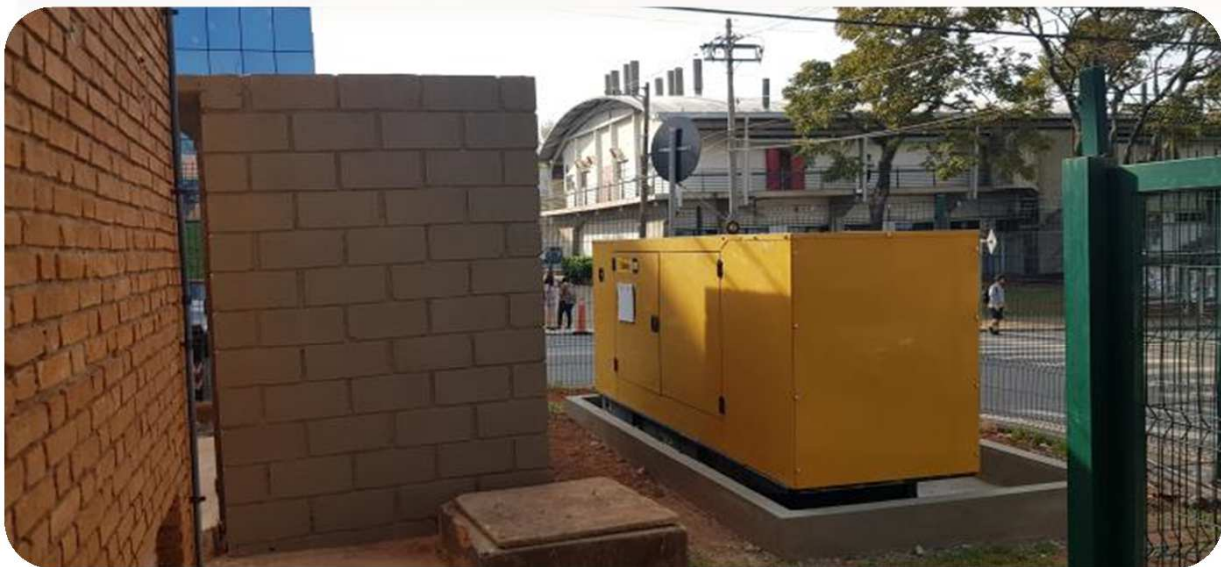
FOTO 1: FOTO DO GERADOR DE ENERGIA INSTALADO.
