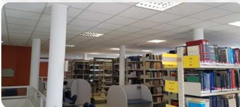
FOTO 7 - DETALHE DA PINTURA INTERNA E SUBSTITUIÇÃO DO FORRO - PRIMEIRO PISO.
