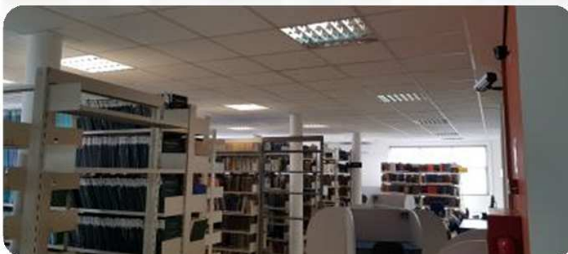
FOTO 8 - DETALHE DA PINTURA INTERNA E SUBSTITUIÇÃO DO FORRO - PRIMEIRO PISO.
