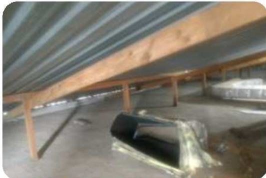
FOTOS 2 e 3: DETALHE DA ANTIGA ESTRUTURA DE MADEIRA DA COBERTURA.
