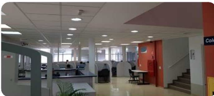
FOTO 6 - DETALHE DA PINTURA INTERNA E SUBSTITUIÇÃO DO FORRO - PISO TÉRREO.
