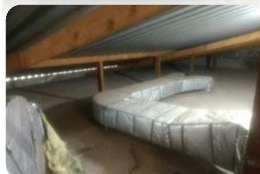
FOTOS 4 e 5: DETALHE DA ANTIGA TUBULAÇÃO DO SISTEMA CENTRAL DE CLIMATIZAÇÃO.
