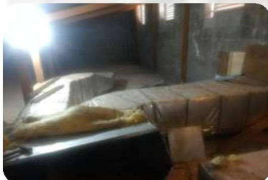
FOTOS 4 e 5: DETALHE DA ANTIGA TUBULAÇÃO DO SISTEMA CENTRAL DE CLIMATIZAÇÃO.
