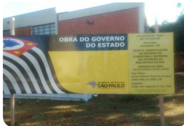
FOTO 1 - PLACA DA OBRA
