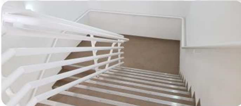
FOTO 10 - DETALHE DO PISO DA ESCADA QUE FOI SUBSTITUÍDO.
