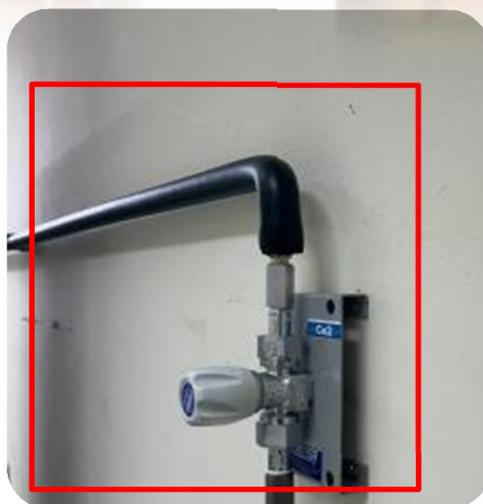
FOTO DO POSTO DE CONSUMO E TUBULAÇÃO COM ISOLAMENTO TÉRMICO
