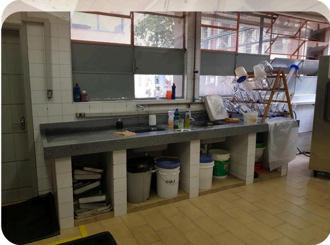
**FOTOS 03 e 04:** Em destaque na imagens as bancadas de granito executadas no Laboratório de Microbiologia Quantitativa de Alimentos/DCA/DECAN/FEA. A obra compreendeu a regularização das superfícies das bancadas com posterior instalação das pedras.
