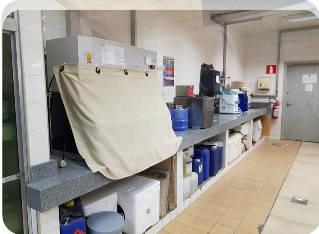
**FOTOS 01 e 02:** Em destaque na imagens as bancasdas de granito executadas no Laboratório de Microbiologia Quantitativa de Alimentos/DCA/DECAN/FEA. A obra compreendeu a regularização das superfícies das bancadas com posterior instalação das pedras.
