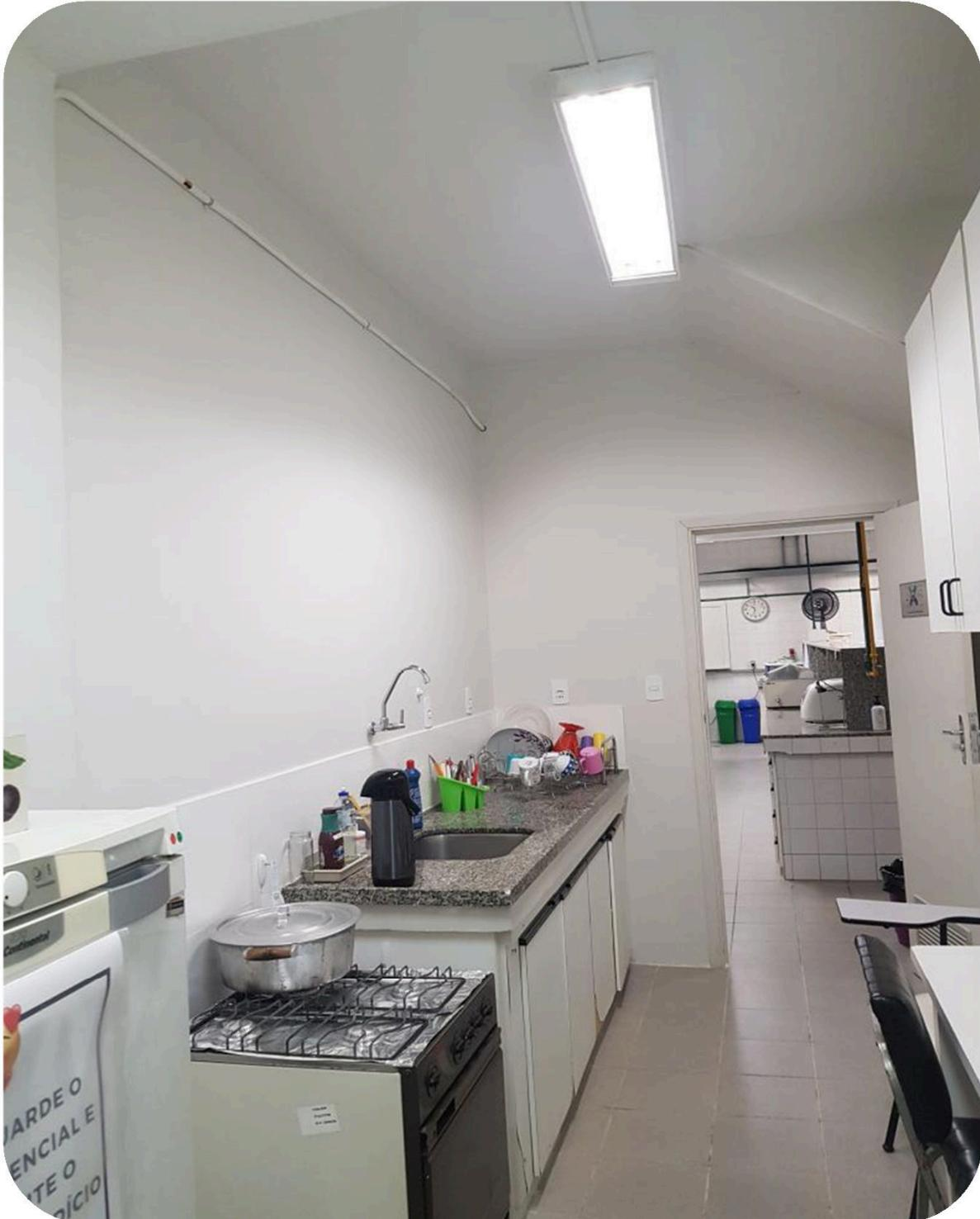
**FOTO 01:** Em destaque na imagens a copa do LB-I/DCA/DECAN/FEA. Na reforma foi removido o revestimento da parede, infraestrutura hidráulica e de gás. Foi executadas novas infraestruturas - hidráulica e de gás, foi aplicado revestimento de gesso nas paredes e tecto. O acabamento foi executado com tinta acrílica na cor branca.
