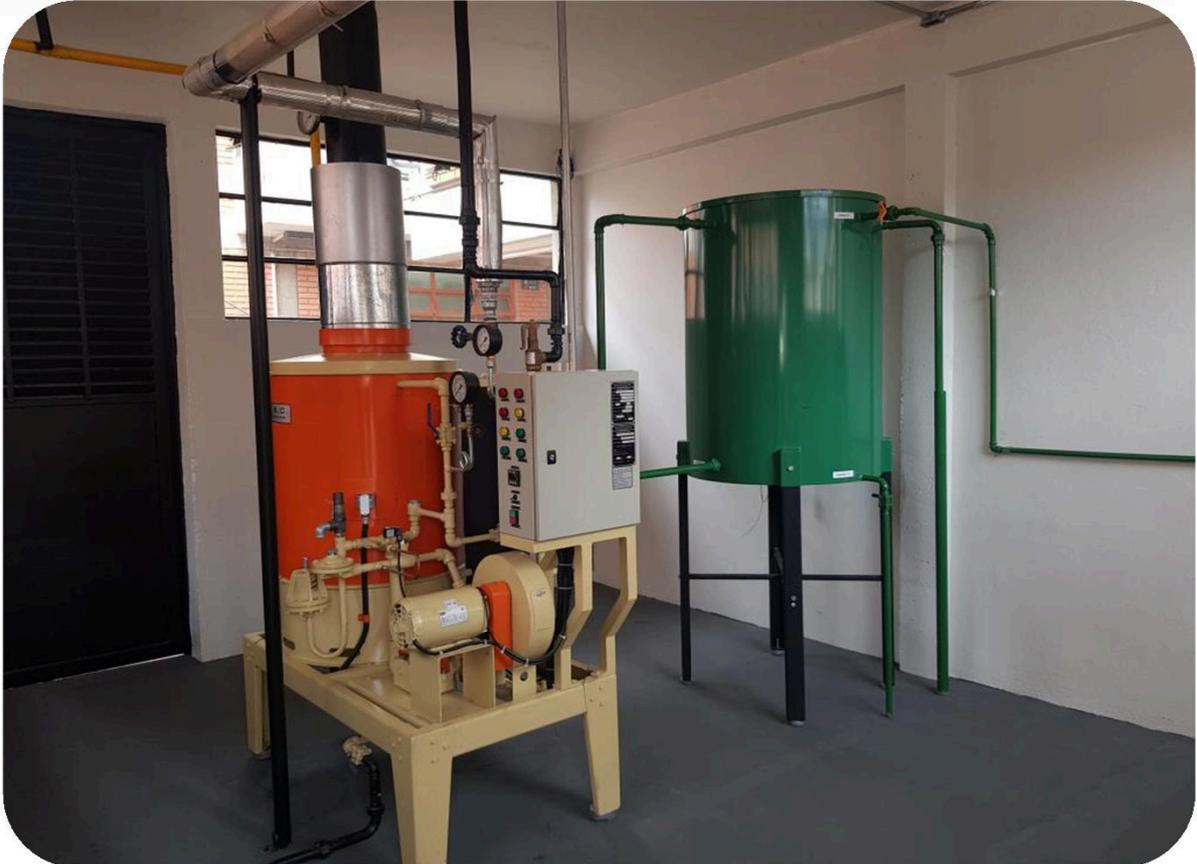
**FOTO 03:** Em destaque na foto o interior do abrigo do Gerador de Vapor Instantâneo. Na reforma foi executado recuperação e pintura das paredes, tecto e piso. Foi executado pintura em toda as ferragens (portas e caixilhos) e foi executado pintura nas redes de água e gás do equipamento.
