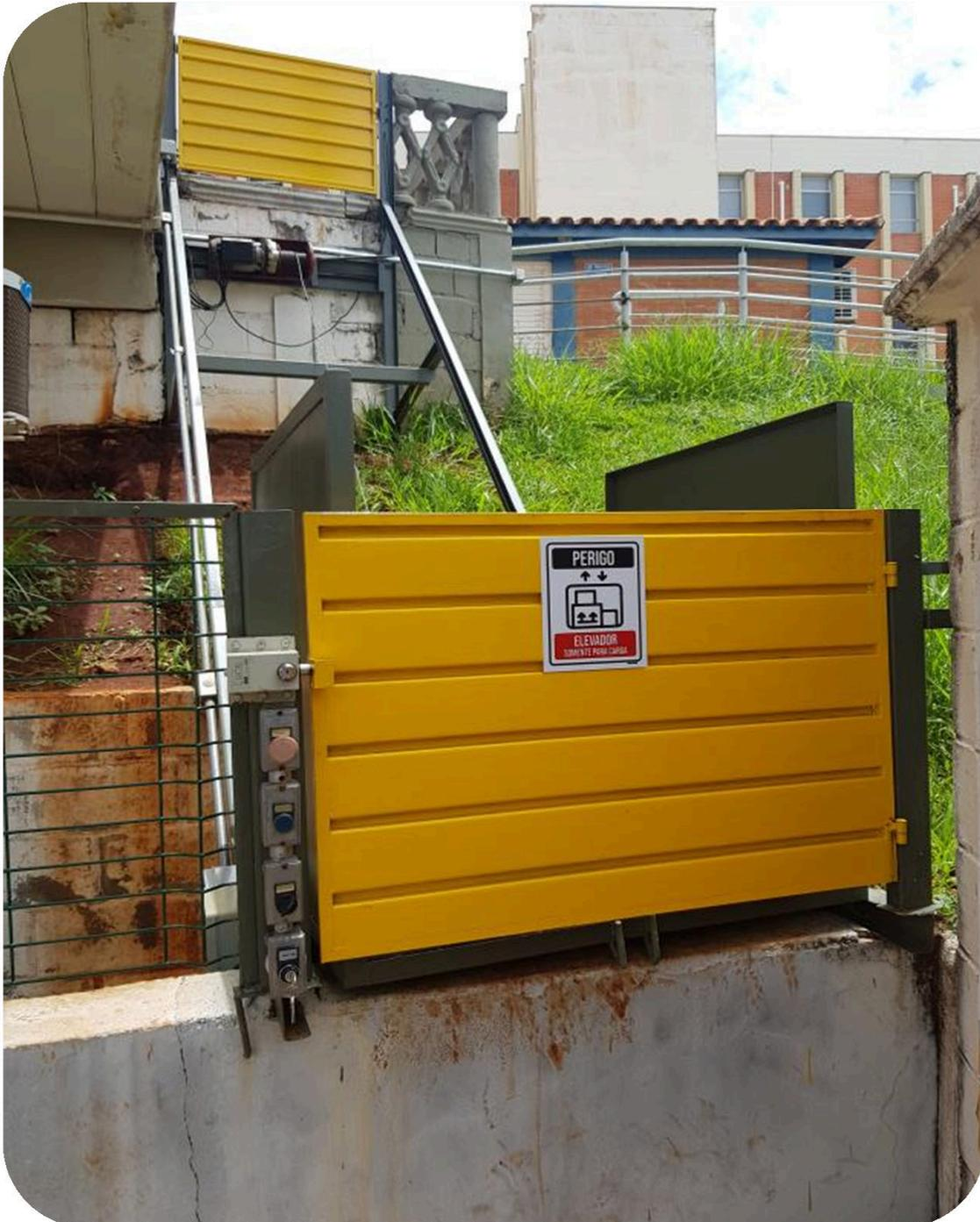
**FOTO 01:** Em destaque na imagem o monta carga do almoxarifado da FEA. Além da pintura, foram substituídos os sensores de fim de curso, sistema de proteção de abertura das portas, foi executado reforço na estrutura dos trilhos e foi feito revisão no guincho do equipamento.
