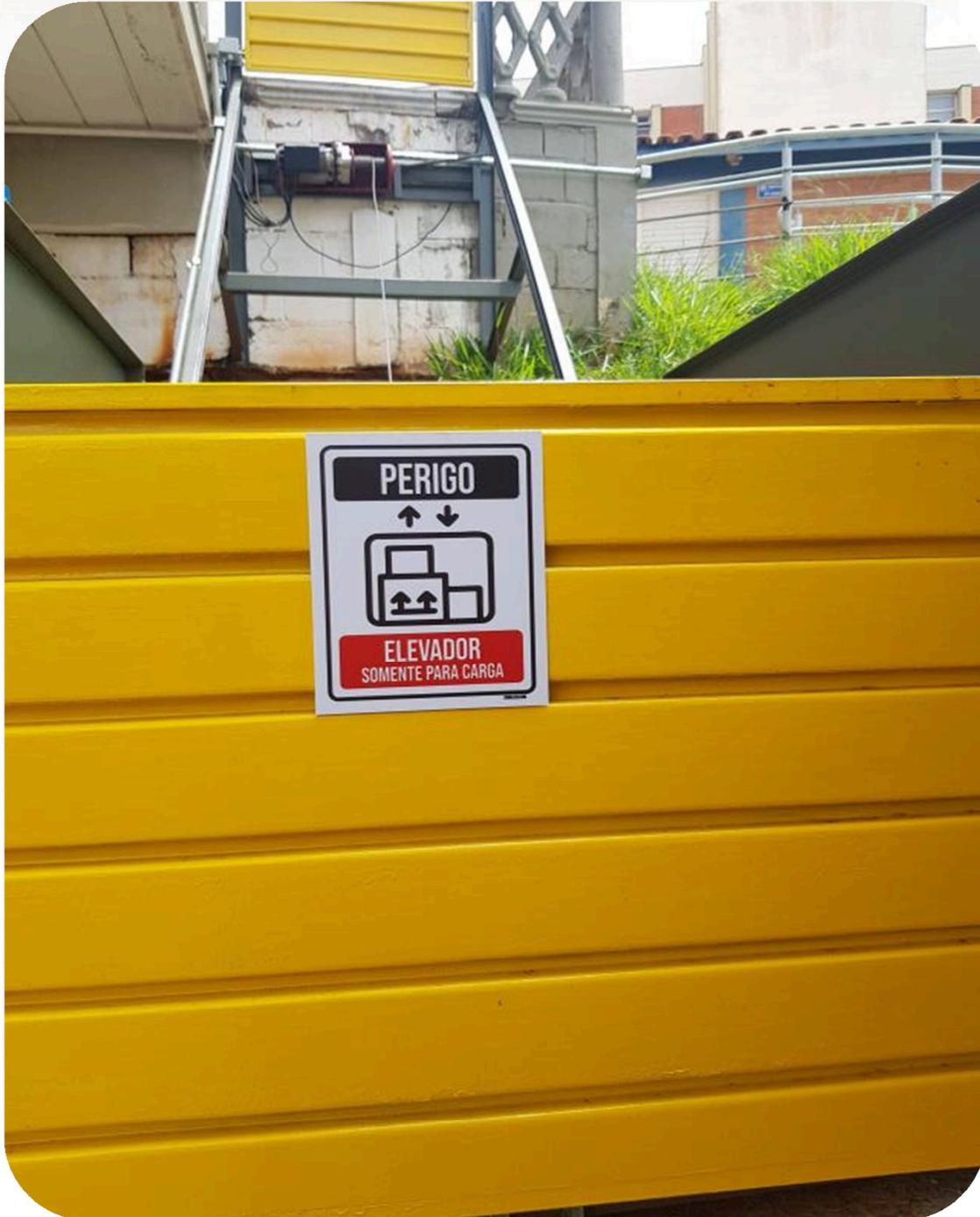
**FOTO 02:** Em destaque na imagem o monta carga do almoxarifado da FEA. Além da pintura, foram substituídos os sensores de fim de curso, sistema de proteção de abertura das portas, foi executado reforço na estrutura dos trilhos e foi feito revisão no guincho do equipamento.
